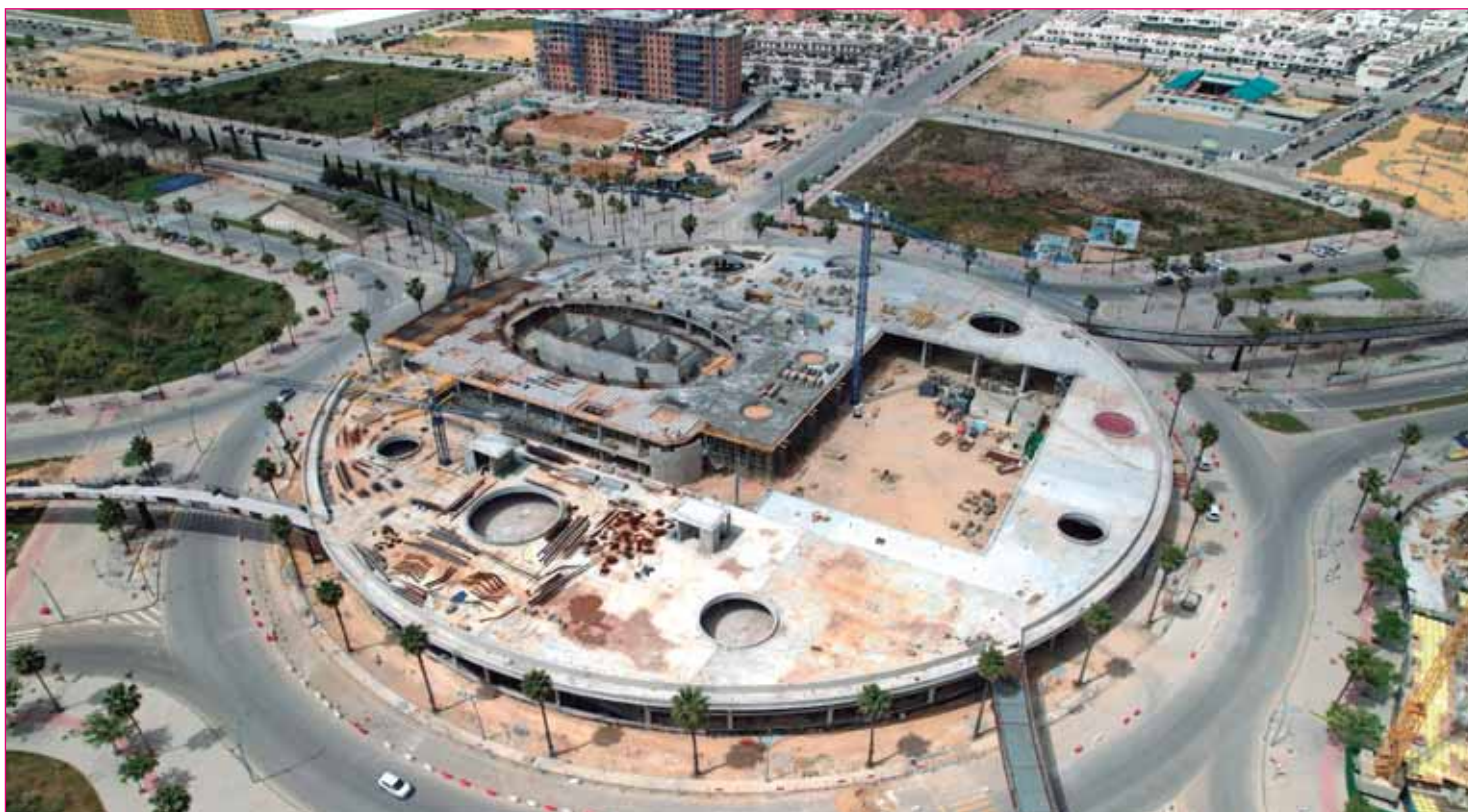
Los trabajos de ejecución para poder finalizar la Gran Plaza de la Torre de Entrenúcleos ya han comenzado.
